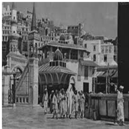
ساختمان اطراف مقام ابراهیم علیه السلام (قدیم)
