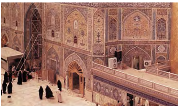
تصویر شماره ۱۳۷. ورودی در رواق جنوبی.
