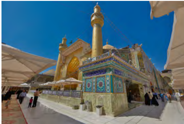
تصویر شماره ۱۸. بخشی از ایوان نمای شرقی ضریح مطهر
