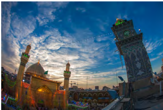
تصویر شماره ۱۲۴. نمای جنوبی رواق حرم مطهر از بیرون.
