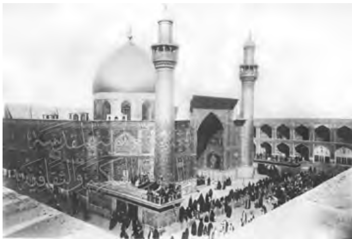
تصویر شماره ۸۱. ورودی شبستان شمالی.
