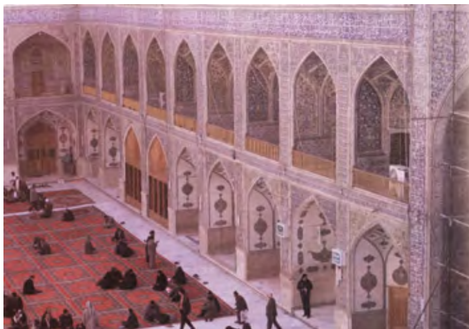
تصویر شماره ۱۰۰. بخشی از نمای شمالی دیوار صحن مطهر، از داخل.
