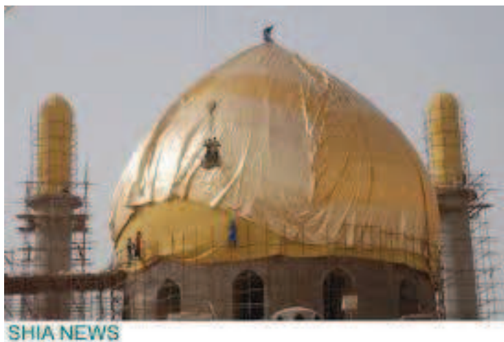
شماره ۵۲ گنبد عسکریین علیه السلام در حال باز سازی
